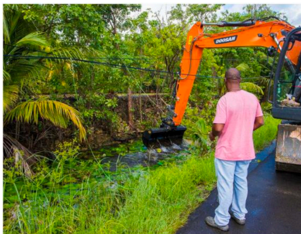
Le curage des canaux est important pour faciliter l'écoulement des eaux des Grands-Fonds et éviter des débordements qui peuvent avoir de graves conséquences.
